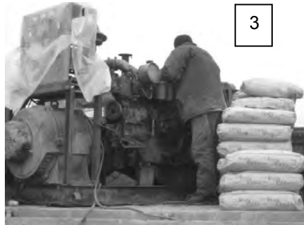
Рис. 1. Комплект обладнання для влаштування ґрунто-цементних елементів за бурозмішувальною технологією
